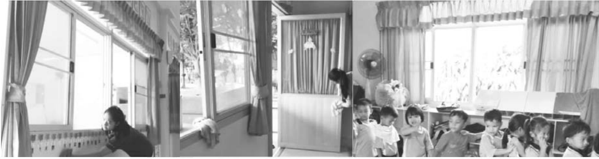
โครงสร้างหน้าต่าง-ประตูห้องเรียน
