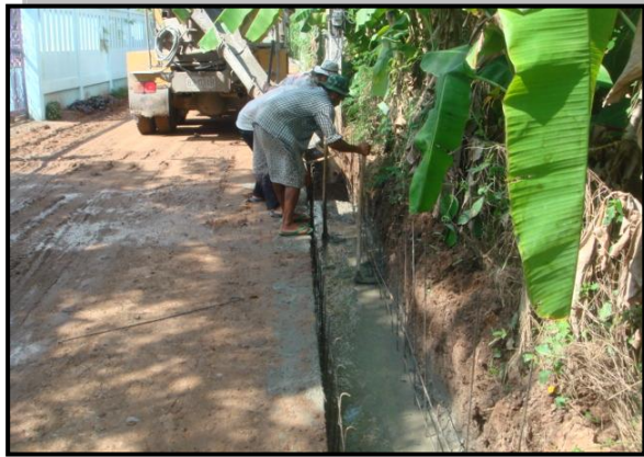
โครงการจ้างเหมาซ่อมแซมถนน ซอยสี่แยกพัฒนา บ้านหนองคู หมู่ที่ 2
