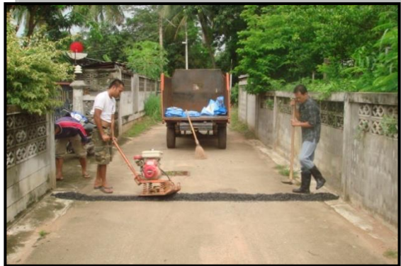
ทำลูกระนาด ซอยร่วมมิตร 1 บ้านหนองซุ่น หมู่ที่ 4
